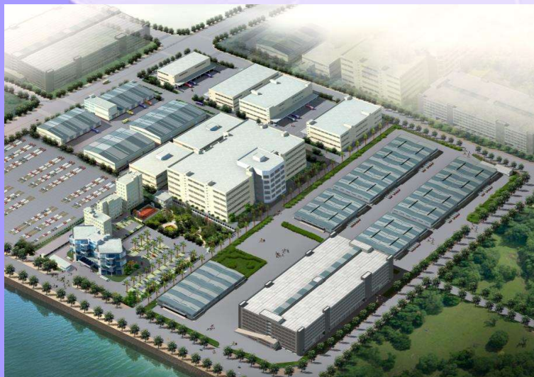
EG新沙港物流センター(500,000M 2 )
